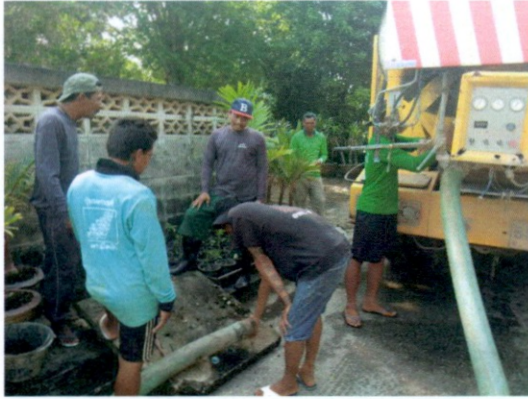
งานป้องกันและบรรเทาสาธารณภัย ร่วมกับกองช่าง สมาชิกสภา กำนัน ผู้นำชุมชน ดำเนินการลอกท่อระบายน้ำที่อุดตัน บริเวณหมู่ที่ ๑ ต.ไร่ส้ม พร้อมได้รับความอนุเคราะห์จากเทศบาลเมืองเพชรบุรี สนับสนุนรถดูดสิ่งปฏิกูล
